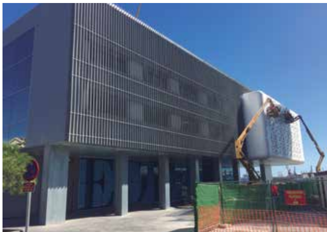
Otro de los aspectos valorados ha sido optimizar su durabilidad en un entorno agresivo como es la primera línea de mar
